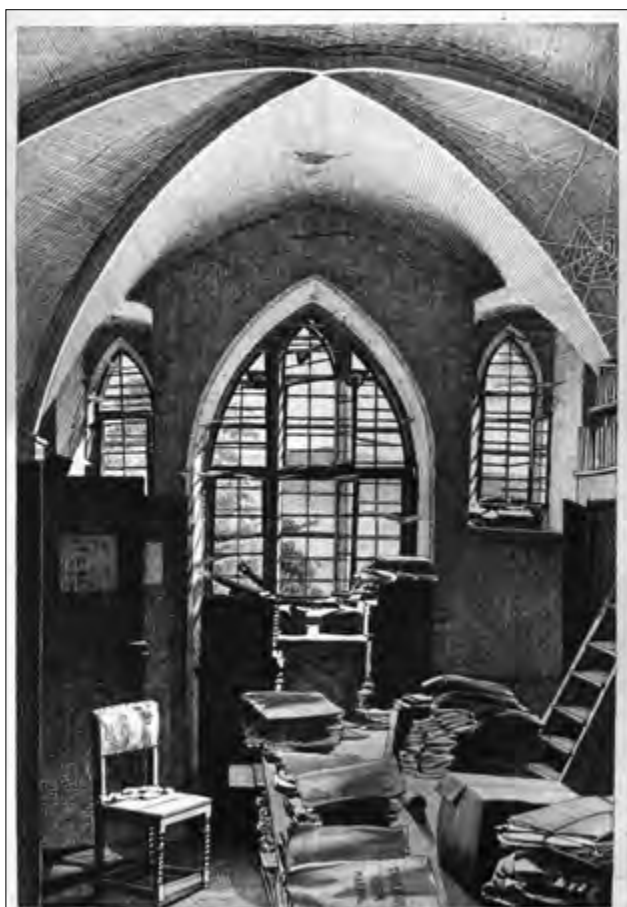
Archivraum neben der Universitätskirche, Zeichnung von Ferdinand Justi, 27. Mai 1878. Dort war das Archiv bis zum Abriss des Aulaflügels 1887 untergebracht. Er existiert noch heute. (HStAM Slg. 7b Meschede Nr. 657)
