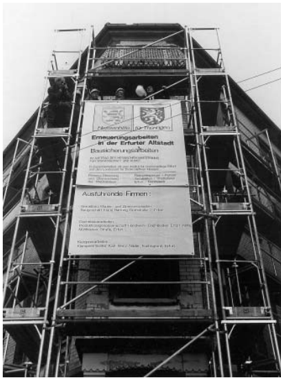
Sanierungsarbeiten in der Andreasstraße im März 1990. Stadtarchiv Erfurt
