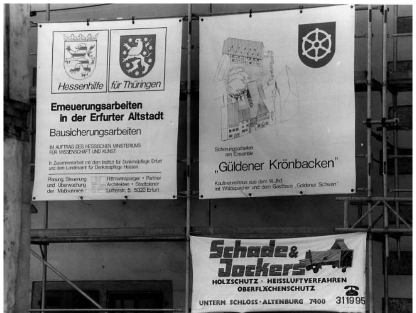
Sanierung des Fachwerkensembles »Güldener Krönbacken« ab 1991. Stadtarchiv Erfurt
