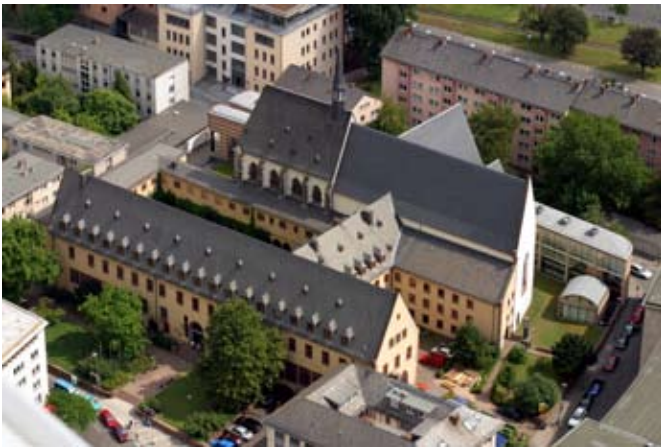
Die Gebäude des früheren Karmeliterklosters beherbergen das Institut für Stadtgeschichte Frankfurt am Main. Foto: Uwe Dettmar.
